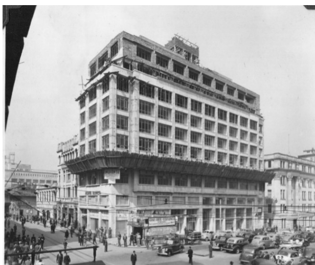
Figura 11. Construcción del edificio Henry Faux (1945-1947).
