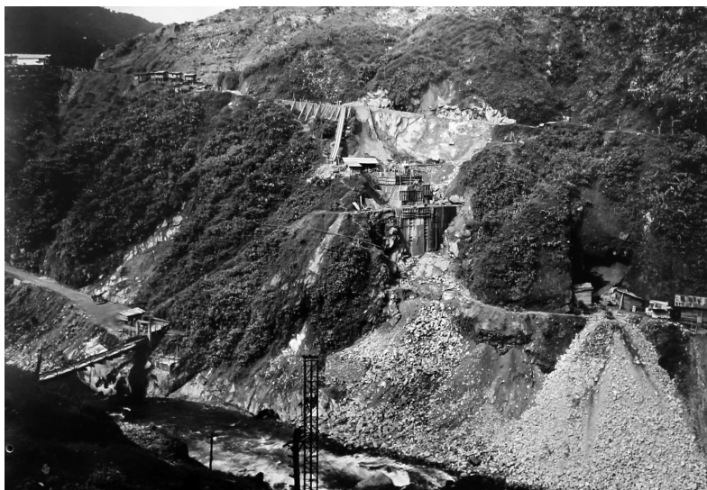
Figura 3-14. Avances en el estribo derecho de la presa de embalse a finales de 1947 en donde se aprecia también el inicio del túnel de conducción.
