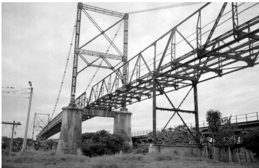
Figura 2-6. Vista del puente de Guayabal, parcialmente desmantelado en 2003. Fuente: foto del autor.
