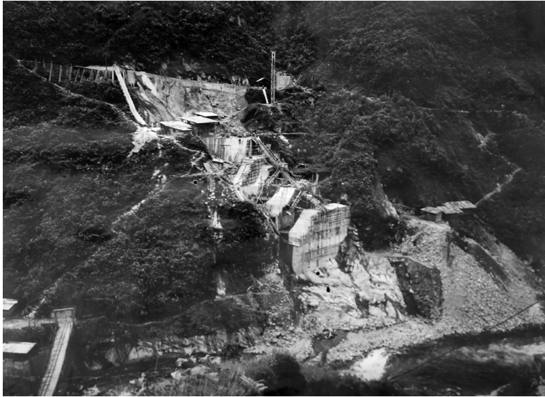
Figura 3-15. Avances en el estribo derecho de la presa de embalse a mediados de 1948 (visto desde el ángulo opuesto).
