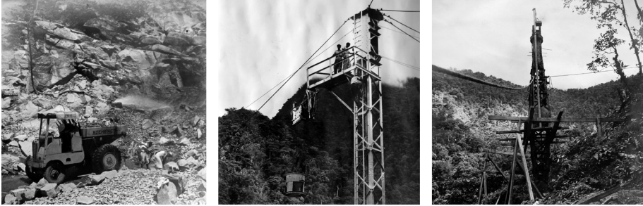
Figura 3-13. (a) Cantera de extracción de material para trituración de agregados, (b) torre metálica del cable-vía, (c) instalación del cable-vía en la orilla opuesta.
