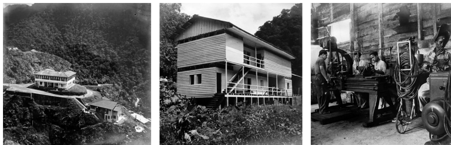
Figura 3-11. (a) Casa para residencia y oficinas, (b) campamento para obreros, (c) taller de mecánica.
