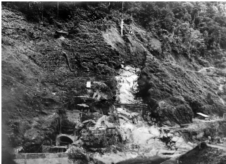
Figura 3-16. Avances en el estribo izquierdo de la presa de embalse a mediados de 1948, destacándose la abertura del túnel de desviación.
