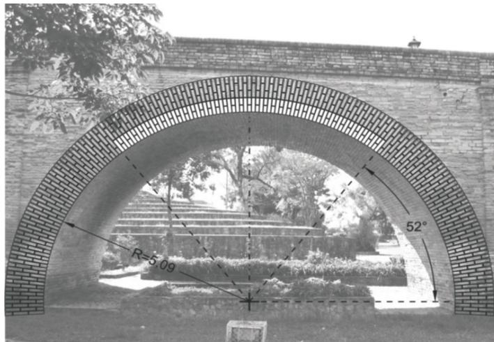
Figura 5. Alzada del arco No. 8 del puente del Humilladero sobre el río Molino, en Popayán (1868). Fuente: Elaboración propia.
