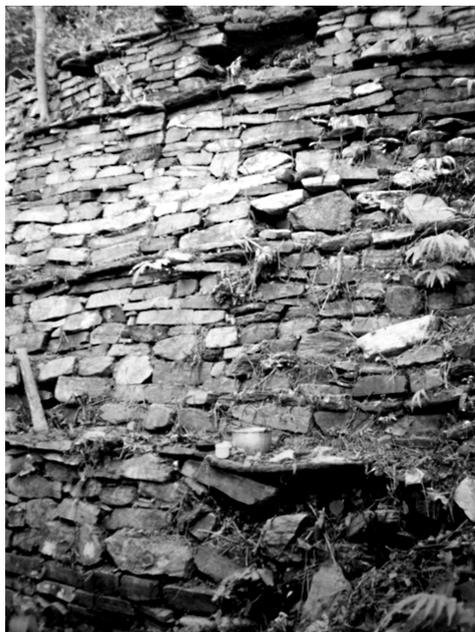
**Foto No. 1.** Los Tairona construyeron cerca de 400 asentamientos en la Sierra Nevada de Santa Marta. Para generar espacios planos, excavaron y rellenaron conteniéndolo con muros construidos superponiendo lajas, como se muestra en esta fotografía de la cara exterior del muro.
