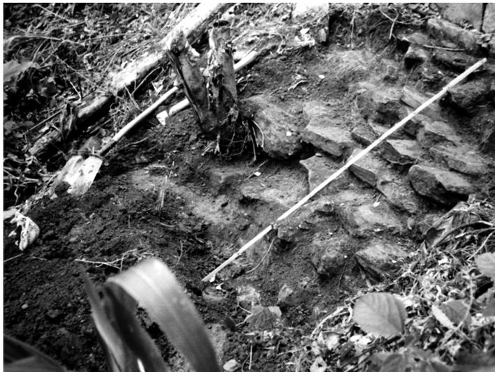
**Foto No. 9.** Al analizar el suelo de cimentación y hacer los cálculos correspondientes al peso del muro, la zapata tenía la anchura requerida según los conceptos actuales.
