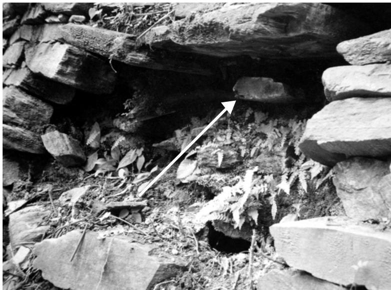
**Foto No.5.** Cara exterior del muro; la flecha indica un tensor.
