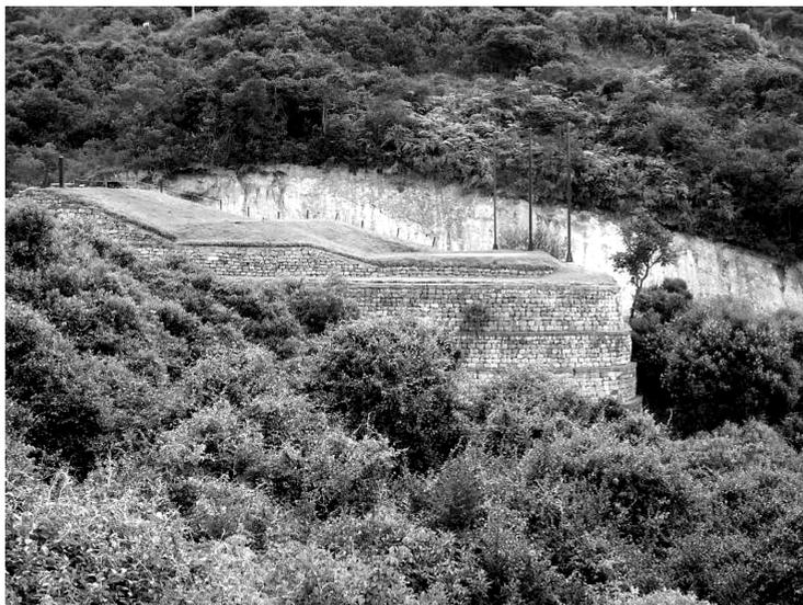
**Foto No. 12.** Muro de 10 m de altura construido con piedras del lugar y tensores de concreto reforzado con mallas, como en la figura No.11.
