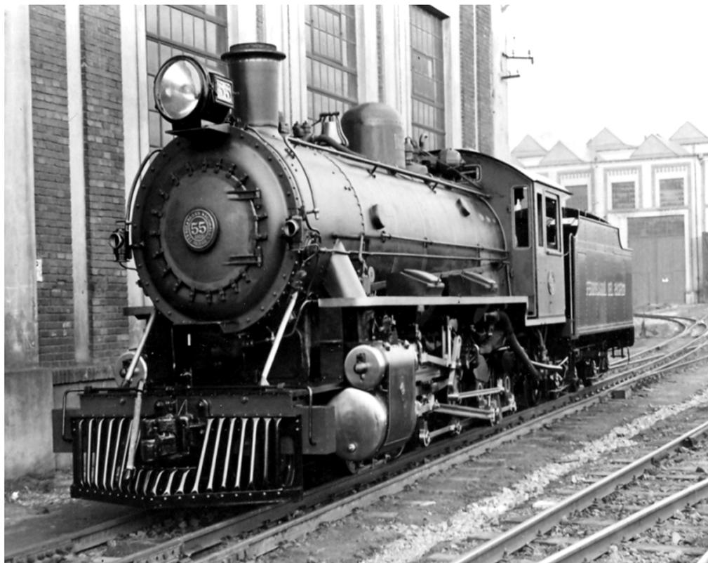
La locomotora No. 55 del Ferrocarril del Pacífico fabricado en 1928 por Skoda, de Plsen, Checoslovaquia, muestra la hermosa estampa de la “locomotora estándar” colombiana con su “Colombian look”, que caracterizó los diseños de P.C. Dewhurst para Colombia y sus condiciones específicas.
