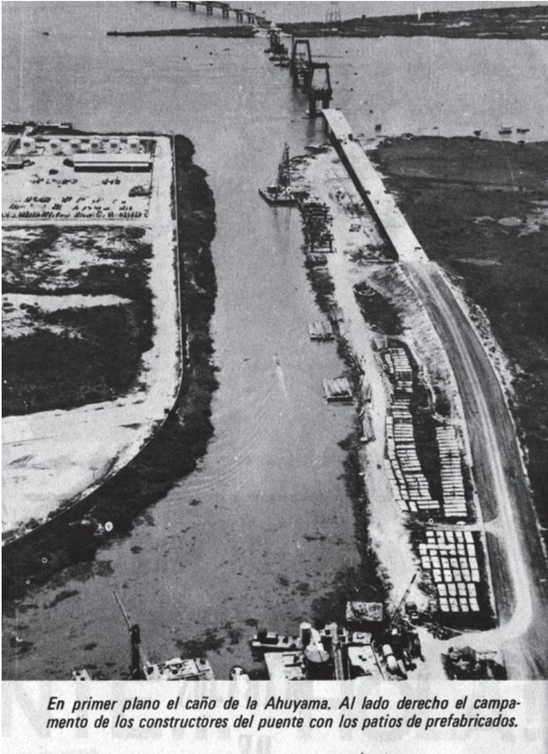
*En primer plano el caño de la Ahuyama. Al lado derecho el campamento de los constructores del puente con los patios de prefabricados.*
